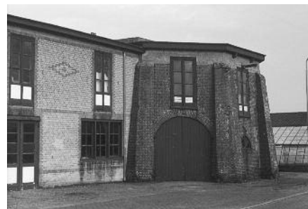
De nog bestaande onderbouw van de Hillegomse molen. Let op de voor westelijk Nederland zeer ongebruikelijke en zware steunbeerconstructie.
