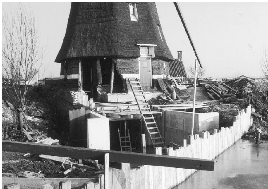
De restauraties van de Waterloosmolen bij Rijpwetering was vanuit diverse oogpunten gezien en ingrijpende en spraakmakende klus (foto J.L.J. Tersteeg, 23 januari 1996).
