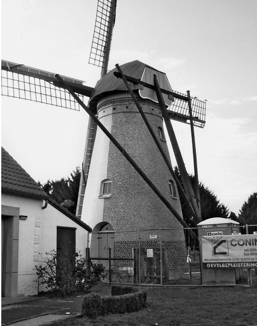
De molen van Kaulille na restauratie, gezien vanuit het zuidoosten. De molen is sinds mensenheugenis gepleisterd. Bij de restauratie werd het herstelde pleisterwerk in een natuurlijke kleur geschilderd met silicaatverf. Het verschil tussen de rode baksteen aan de basis en de gele ijsselsteen hogerop is duidelijk zichtbaar.
