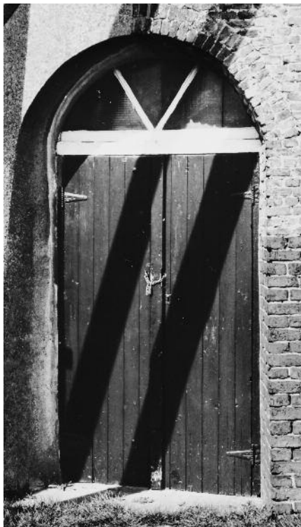
Molendeur op het zuiden in 1988. De molen heeft deuren in drie richtingen. Niet alleen het kleurverschil maakt het verschil tussen de rode baksteen en de ijsselsteen duidelijk, maar ook het formaat. De ijsselsteen is namelijk een zeer kleine baksteensoort, circa 15 x 7 x 4 cm.
