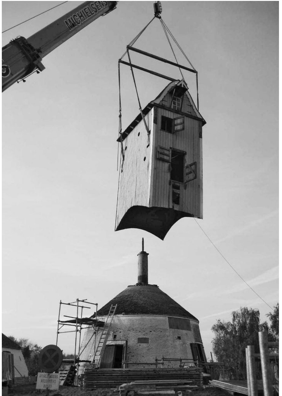
De Oostmolen wordt van het torenkot gelicht. Niet alleen de (doorboorde) standaard is goed zichtbaar, maar ook de spil die zorgt voor de aandrijving van het oliewerk in het torenkot (foto Benoît Delaere, 7 november 2006).
