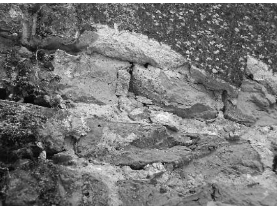
De pogingen om de pleisterlaag te verwijderen ging met ernstige beschadigingen van de zeer zachte ijsselsteen gepaard.
