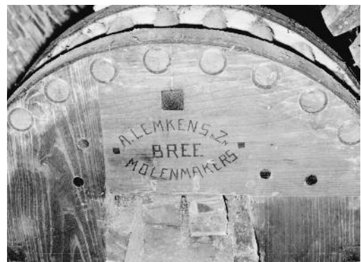
Steenrondsel met naam van de molenmaker.
