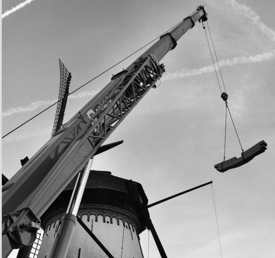
Het aanbrengen van een nieuwe penbalk in de molen van De Marsch in Lienden (foto A. Nibbelink).
