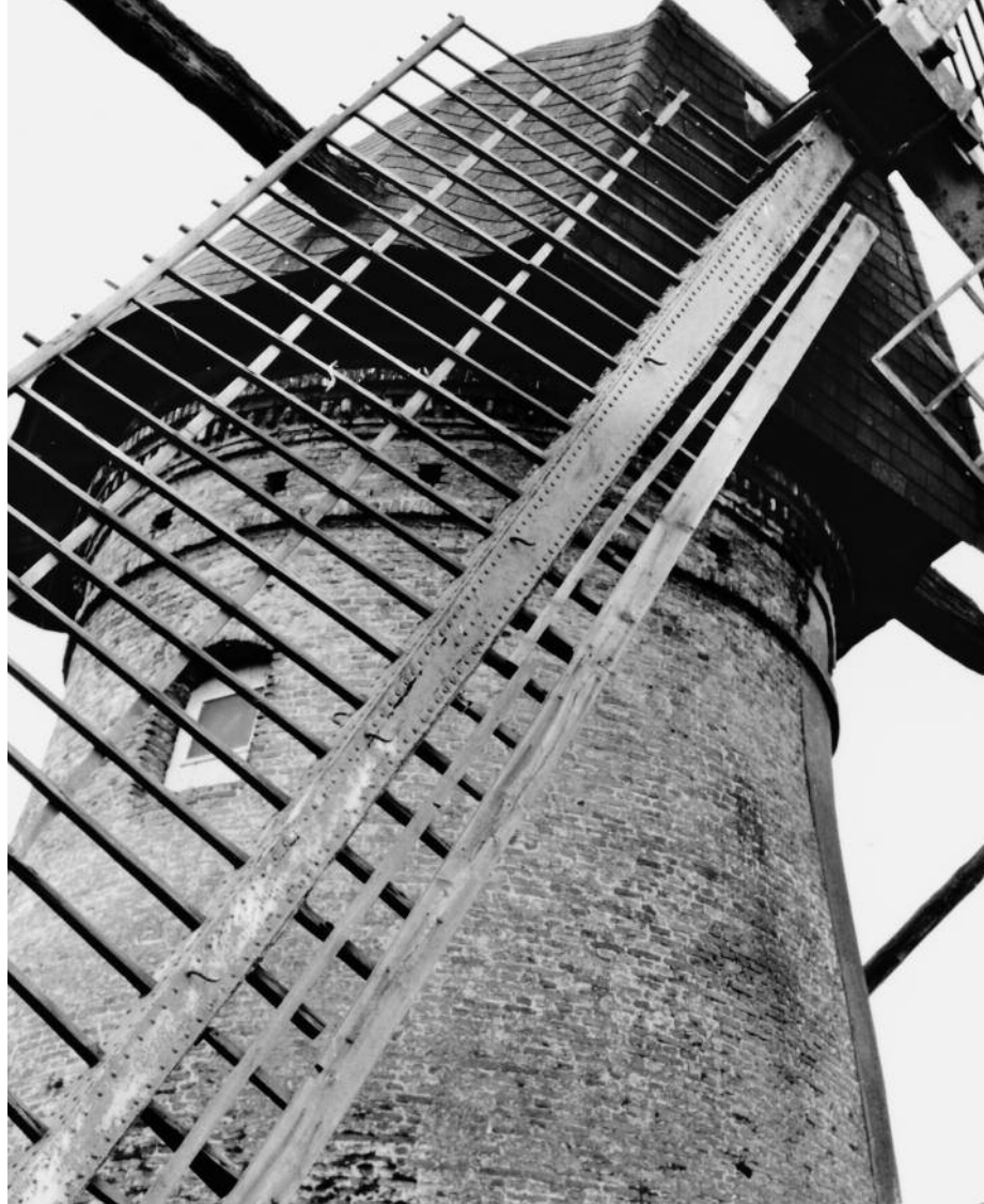
De molen heeft een vlucht van 23,90 m en sinds 1993 twee Derckxroeden (no. 746 en 747). Voordien bezat de molen geklonken roeden. De buitenroede was in 1932 geleverd door Verhaeghe-Decuyper uit Ruddervoorde, nummer 1174. De binnenroede had het model van een Knesselareroede.
