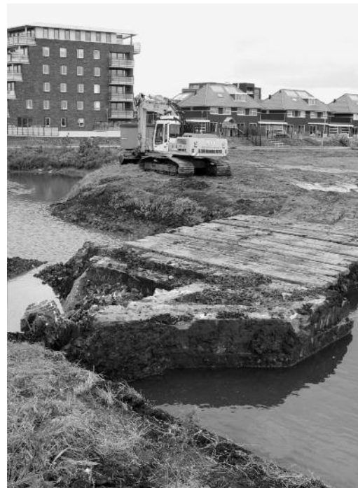
Restant van de fundering van de ondermolen van de Oud- en Nieuw-Wateringseveldpolder, kort voor de totale sloop (foto E.G.M. Esselink, november 2006).
