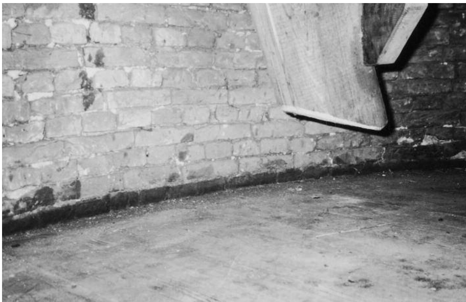
Ook op de kapzolder is de verhoging te zien aan het verschil in metselwerk (foto Kees de Haas, 9 oktober 2006).
