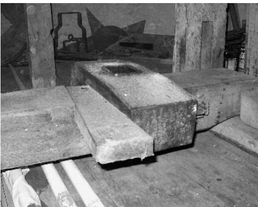
De pasbalk in Den Arend ligt bijzonder laag, net boven de vloer (foto Jan Bakker).
