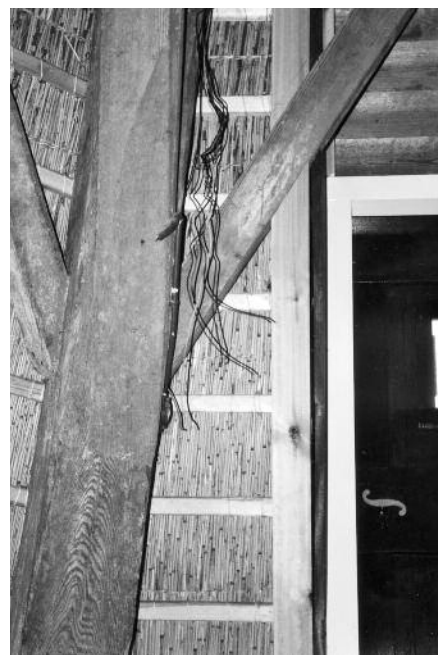
De uitgeholde noordwestelijke korbeel van De Jonge Sophia met rechts de noorddeur op het tafelement. De hoogte van de uitholling toont aan dat de halve zolder met de stenen flink onder het tafelement moet hebben gelegen.
