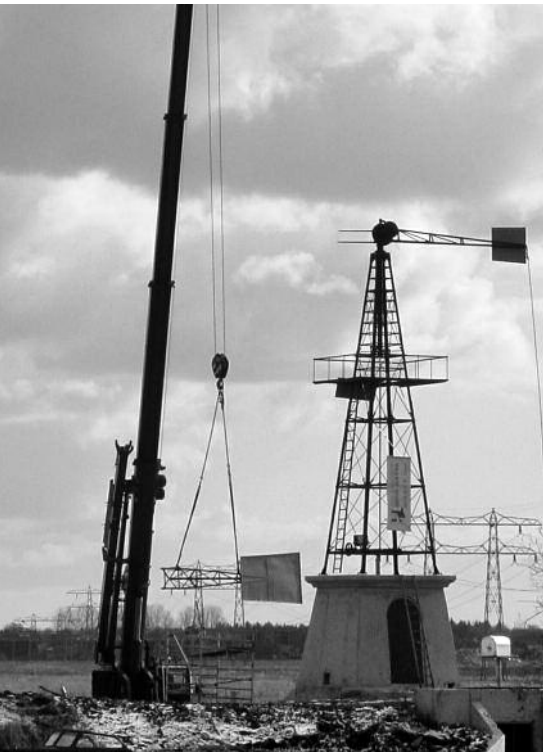
Plaatsing windvaan op de molen van de Kropswolderbuitenpolder (foto: K. Noot-Schilderman 23-02-2004).
