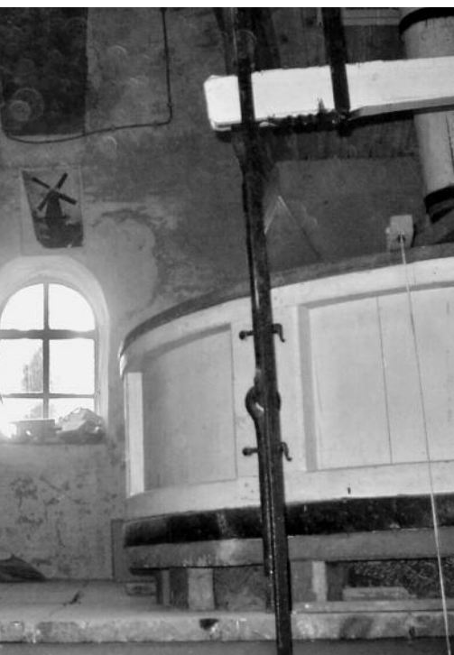
Interieur van vermoedelijk een wipkorenmolen in Haastrecht (zie Molenwereld 2001-12-316). Afgaande op het aantal trap treden is ook hier de halve zolder circa een meter hoog.
