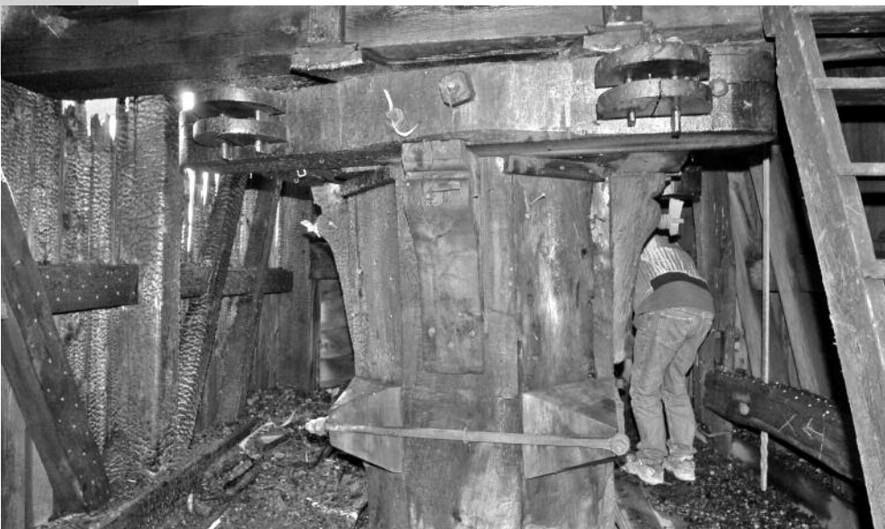
De koker met de bovenzetel; links zijn de vlammen overduidelijk uit het bovenhuis geslagen (foto W. van Veen).
