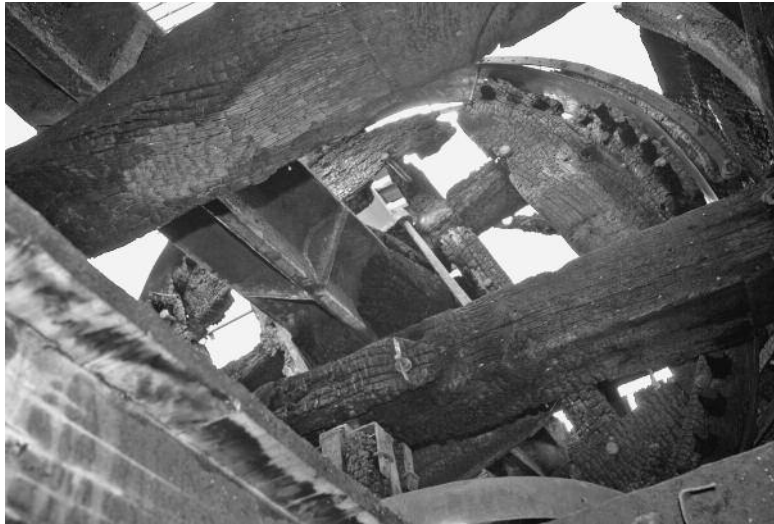
In het bovenhuis: van de vang is vrijwel niets meer over dan de ijzers en het bovenwiel is ook grotendeels verkoold. De ijzeren voering ligt er los bij. Wonder boven wonder zou de as er ook nog vrij goed afgekomen zijn (foto W. van Veen).
