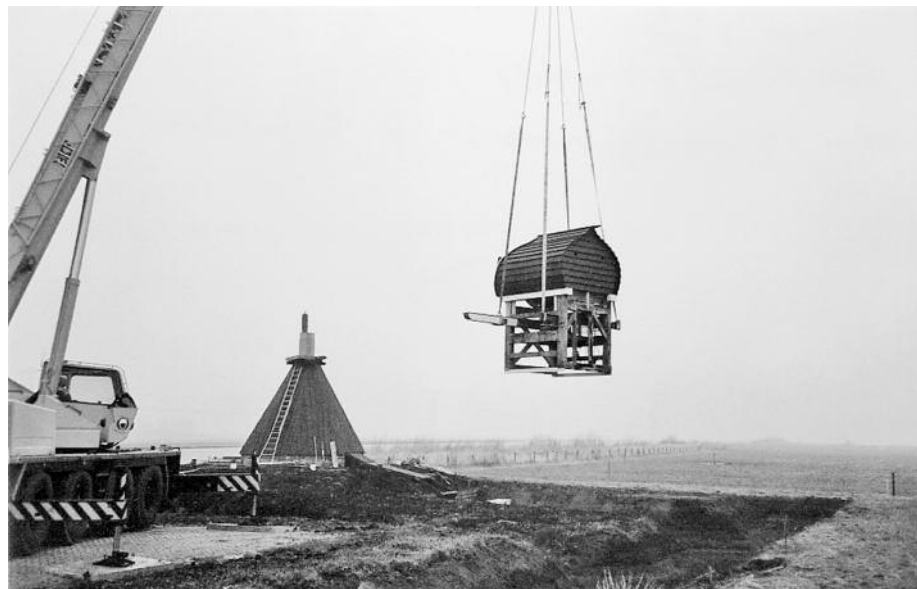
Het bovenhuis van de Polslootpoldermolen in de takels (foto: P. Timmermans 12-02-2004).
