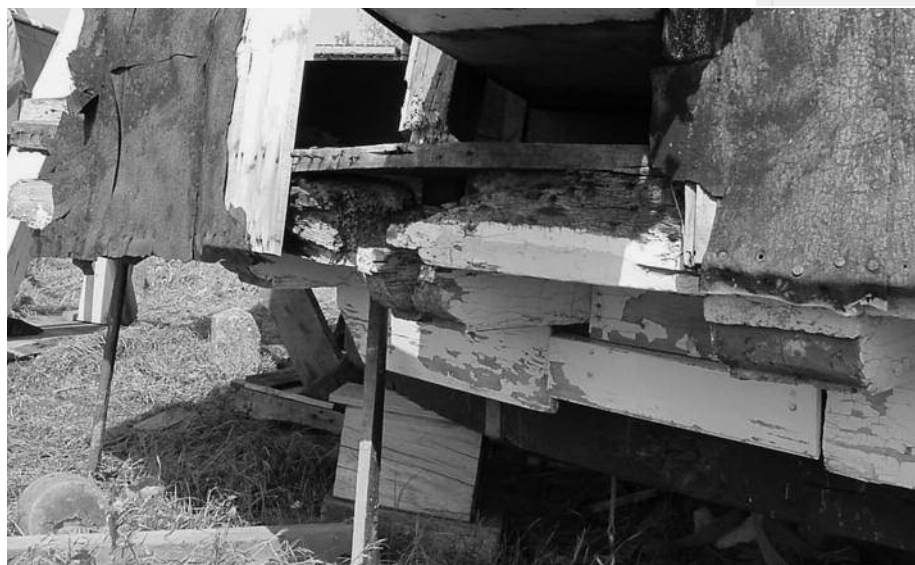
De resten van de overkuip aan de kap van De Zwaan (foto Vaags).
