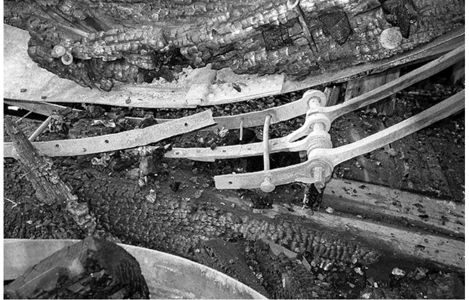
Het gebroken vangijzer van het buikstuk (foto P. Groen).
