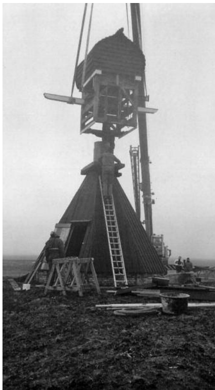
Het bovenhuis wordt op de ondertoren geplaatst (foto: P. Timmermans 12-02-2004).
