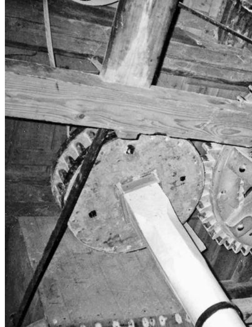
Interieur korenmolen Den Arend in Bergambacht met een opvallend klein spoorwiel, afkomstig uit de voorganger, een wipmolen (foto Jan Bakker).
