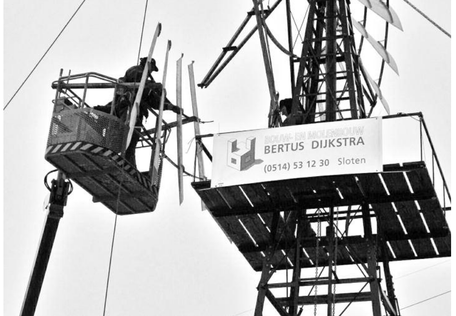
Het aanbrengen van het windrad op 26 februari (Kropswolderbuitenpolder) (foto: K. Noot-Schilderman 26-02-2004).
