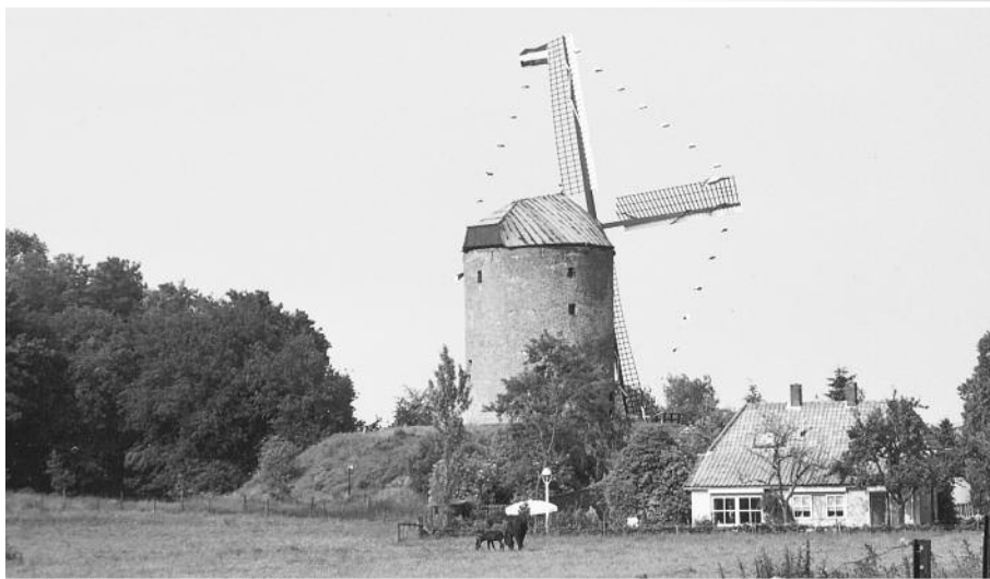
b) De situatie in 1991: kleine boompjes worden groot en dan is Leiden in last!
