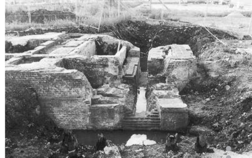
De molenvoet vanaf de kant van de geheel verdwenen voorwaterloop, waarvan de heipalen wel zichtbaar zijn. Bij de linker rij palen is nog een hardstenen slagstijl voor de wachtdeur zichtbaar. Let op de uitgehakte opleider.
