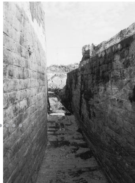
De molenvoet vanaf de kant van de geheel verdwenen voorwaterloop, waarvan de heipalen wel zichtbaar zijn. Bij de linker rij palen is nog een hardstenen slagstijl voor de wachtdeur zichtbaar. Let op de uitgehakte opleider.
