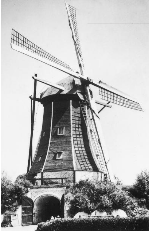
De molen van Zeilberg, ex Wateringen, voor de restauratie in 1964, waarbij de romp met riet werd gedekt. Jammer genoeg hield deze molen bij de verplaatsing in 1893 zijn originele baarden niet.
