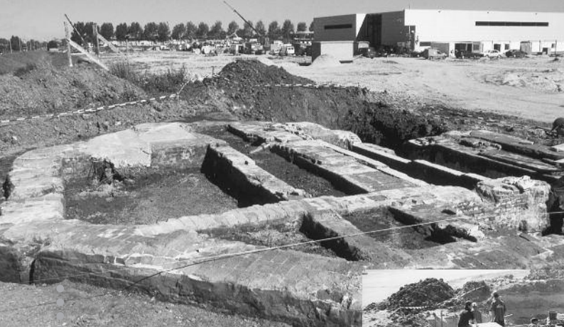
De gedeeltelijk uitgegraven voet van molen 2 in Wateringen. Links, in het verlengde van de keermuur, de inkassing voor het scherm. De draagmuur, de keuken- en de kelder muur zijn duidelijk te onderscheiden, evenals de wielbak.
