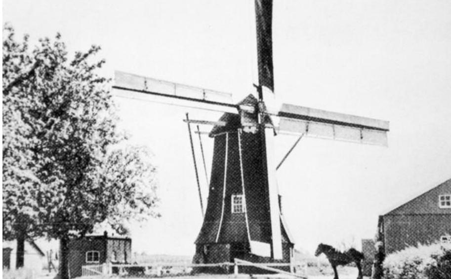
De korenmolen van Vragender met het in 1939 aangebrachte Ten Have systeem. De stroomlijnneuzen wijken duidelijk af van die van Van Bussel.
