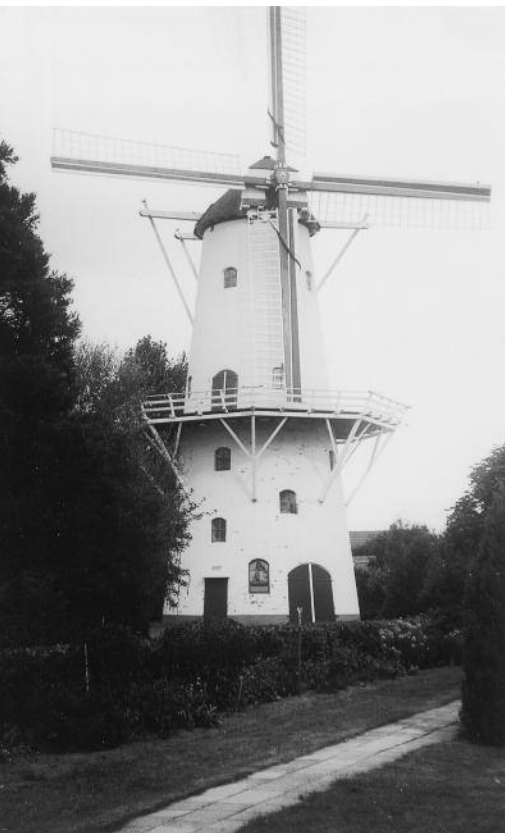
De molen van Bellingwolde in juli 1976. De molenromp was toen met een witte coating behandeld om inwatering tegen te gaan. Aangezien dit weinig hielp herkeeg de molen in 1979 zijn uiterlijk met 'schoon metselwerk' weer (foto P. Grund).
