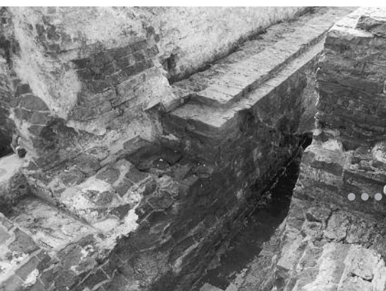
De gedeeltelijk uitgegraven voet van molen 2 in Wateringen. Links, in het verlengde van de keermuur, de inkassing voor het scherm. De draagmuur, de keuken- en de kelder muur zijn duidelijk te onderscheiden, evenals de wielbak.
