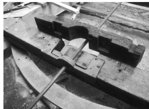
Reeds eerder kwamen in de molen van Rha bijzondere constructies aan het licht; toch was daarmee niet alles genoemd. De constructie van het penlager van de as is ook niet normaal (foto A. Nibbelink).
