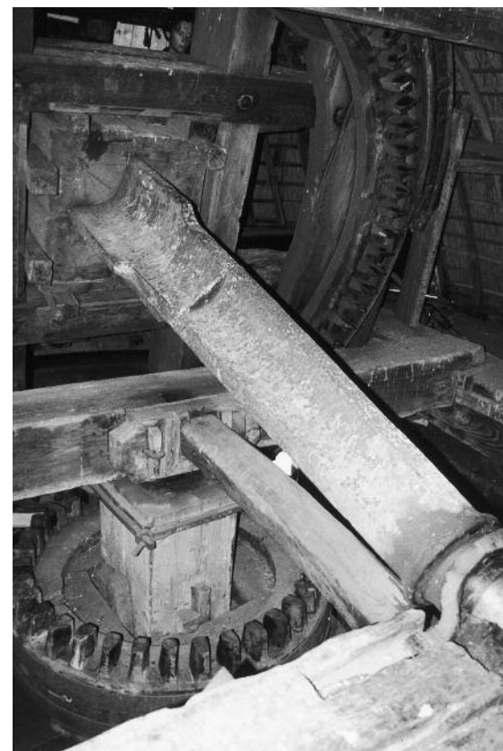
Het bovenwiel van de molen in Zeilberg met de konkelaar. De beroete kap en wielen onderstrepen het verleden van de molen als bewoonde watermolen. Let op de enkele stut tussen poortstuk en penbalk. Dit zou wel eens de oorspronkelijke stut tussen penbalk en wolfsbalk geweest kunnen zijn.
