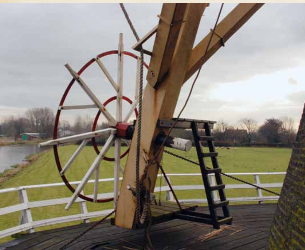
▼De staart met zijn dubbele kruibank; links de IJssel (foto Dick Kenbeek, 12 december 2012).
