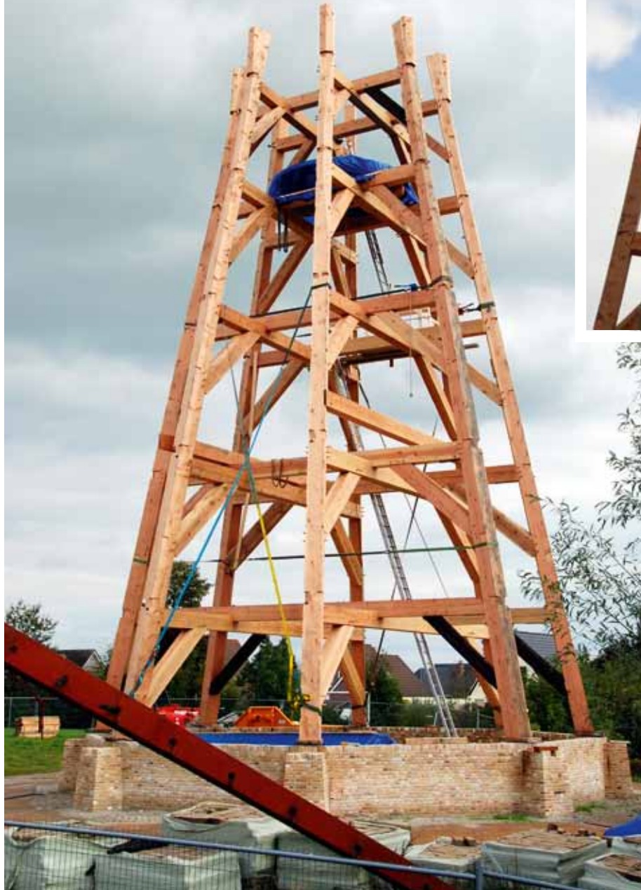
▲ Het nieuwe achtkant voor de molen van Burum staat overeind. Enkele korbels zijn nog van de oude molen; te herkennen aan de geblakerde toestand (foto H.Noot, 6 oktober 2013).
