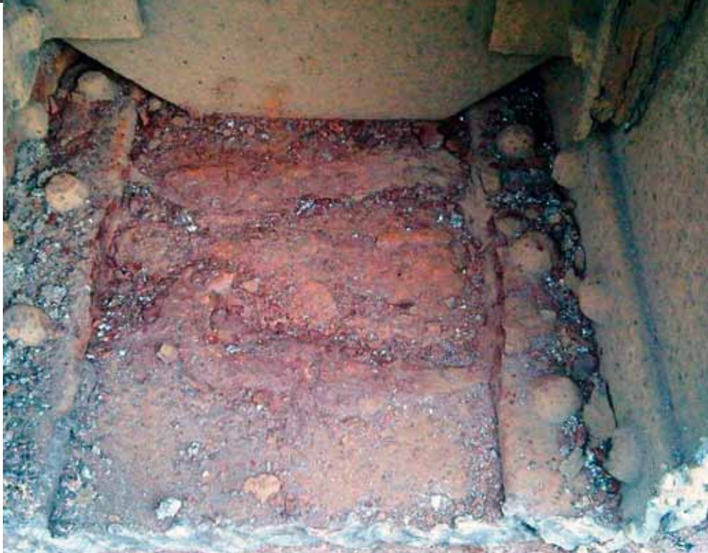
▲ Potroe aan de binnenzijde; het roest heeft zijn werk gedaan; de snijbrander ook; roede uit de molen van de Stevenhofjespolder in Leiden, de molen in Rijnland die als laatste nog met Potroeden draaide (zie Molenwereld 2012-03-114 e.v.).
