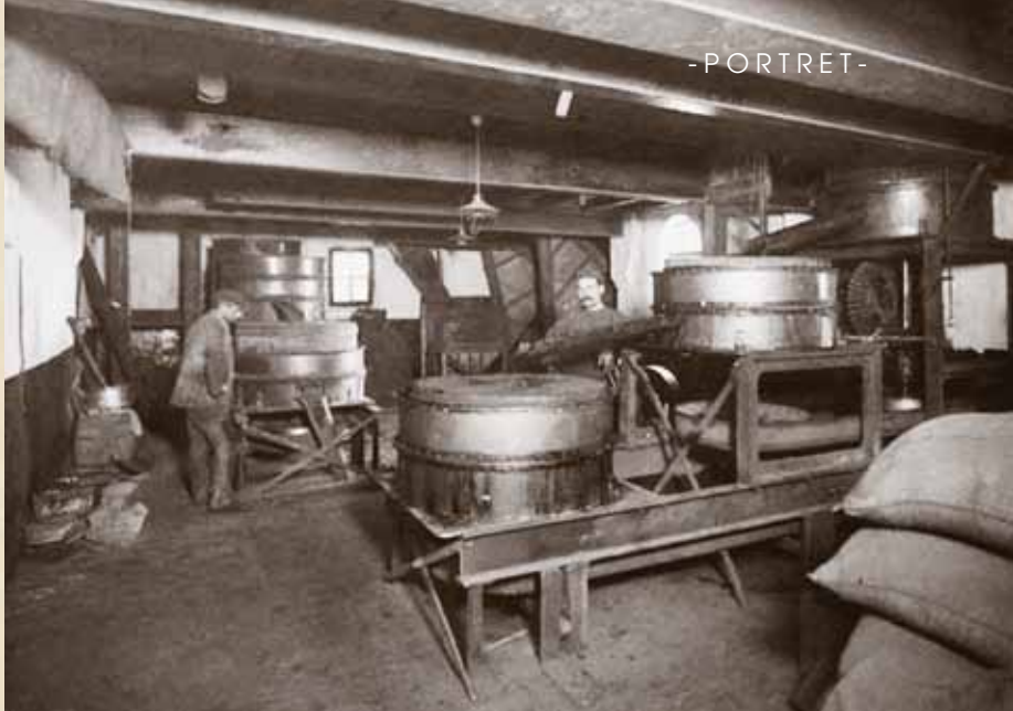
▲De cacao werd in de fabriek op platte stenen gemalen volgens een cascadesysteem. De uitloop van de bovenste steen liep naar het kroggat van de tweede steen en van de tweede steen naar de derde. De stenen hebben onderaandrijving met riemen rechtstreeks op de maalspillen.
