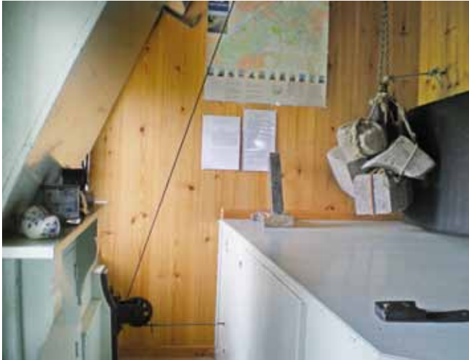
▲De grijze 'tafel' rechts is de omtimmering van de grote riemschijf en de riem voor de aandrijving van de schroefpomp. De kabel met het contragewicht is van de riemspanner. De voormalige schoorsteen links herinnert nog aan de tijd dat de molen bewoond was (foto Andries Veloo, 26 april 2012).
