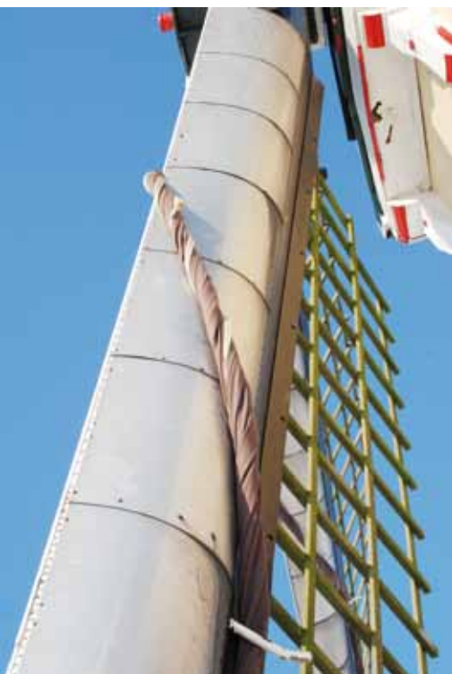
▲De halve verdekking aan de achterzijde van de roe (foto D. Kenbeek, 11 februari 2012).
