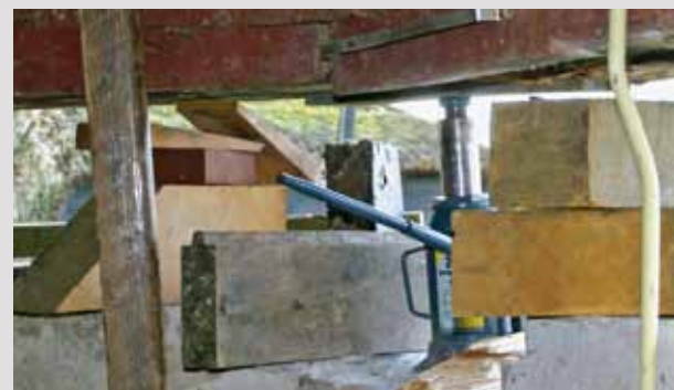
▲ Met hydraulische vijzels is de romp weer rechtgezet.
