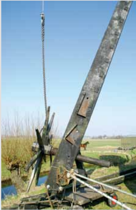
▲ De staartbalk is duidelijk een oude roe, herkenbaar aan de dichtgelaste hekgaten.
