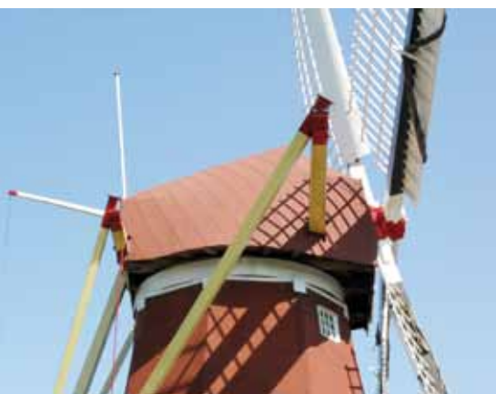
De molen van Budel-Schoot met zijn Icopal dak- en rompbedekking. Chris van Bussel had een grote voorliefde voor dit materiaal en het gebruik is vaak op hem terug te leiden (foto Rob Simons, 12 april 2012).
