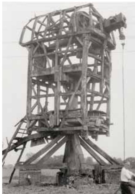
▲ De molen in Oberlangen tijdens de demontage. De foto geeft een goed inzicht in de constructie van de molen. De steen op de bovenste zolder is een maalsteen, de onderste is een pelsteen (foto archief Mühlenhof-Freilichtmuseum Münster).
