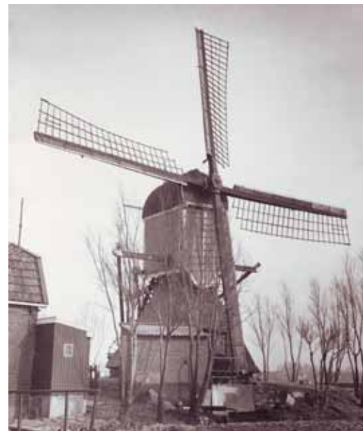
▲De Groenendijkse molen omstreeks 1960. De molen is buiten bedrijf. De molenwerf rond de molen is beplant met bomen! In het gebouwtje met het golfplaten dak staat een dieselmotor van 30 pk die de schroefpomp aandrijft. De uitlaatpijp is duidelijk zichtbaar. Naast het gebouwtje rechts de brandstoftank en links het woonhuis (foto A. Bicker Caarten, coll. Ruud Bax).
