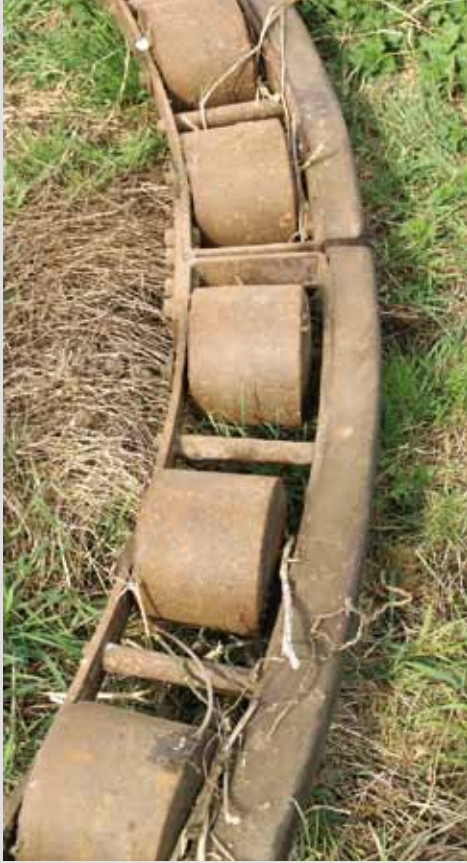
▲ Het kruierwerk met gietijzeren rollen en ijzeren rollenwagens plus houten velgen aan de buitenzijde.
