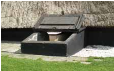
▲De geopende pompput met de riemaandrijving op de pompas (foto Andries Veloo, 26 april 2012).
