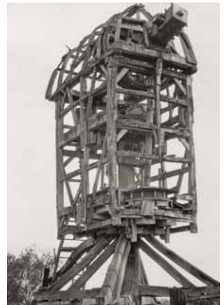
▲ Nogmaals de molen in Oberlangen tijdens de demontage. Let ook op de pasbalk voor de pelsteen onder de voeghouten (foto archief Mühlenhof-Freilichtmuseum Münster).
