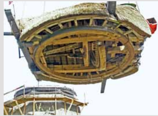
▲ Vliegende kap; ook de langespruit is een oude roe. De voeghouten zijn niet mis.
