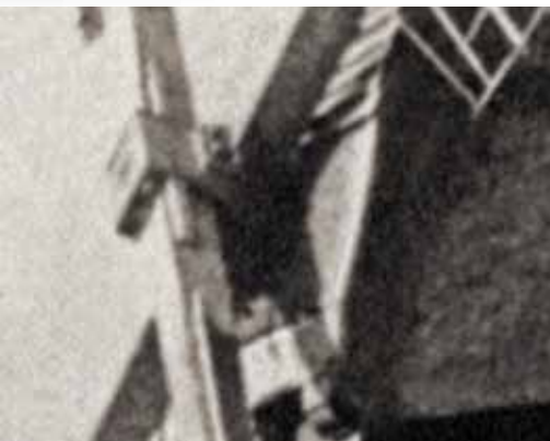
▲De askop van de bovenmolen van Schiebroek. Frappante overeenkomsten met de as van De Vrijheid zijn de gladde wanden van het (voorste) ashuis en het vrijwel geheel ontbreken van de walpen. Het kan haast niet anders of Nolet moet de as in Schiebroek hebben gezien.
