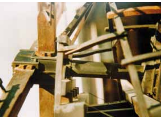
▲De lagering van de as (in het model van brons) is heel bijzonder. Op de eigenlijke windpeluw liggen klossen met daarop weer een windpeluw waarop op een gietijzeren (?) kussenblok is gemonteerd waarop de as is gelagerd. Dezelfde constructie is zichtbaar op de tekening van Storm Buysing (foto ing. J. den Besten).
