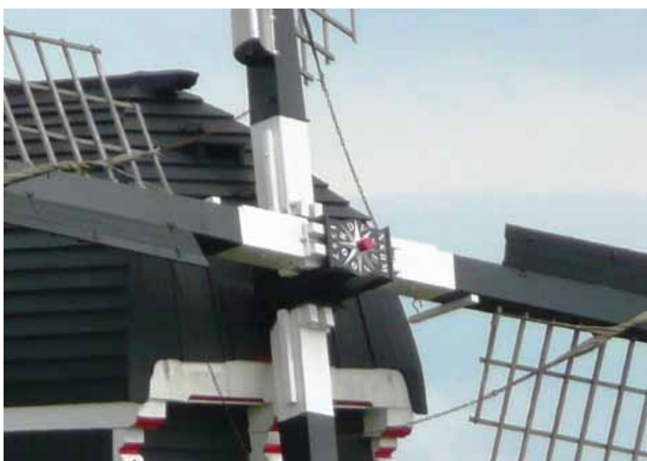
▲ De Oudendijkse molen in Hoornaar heeft een NSBM-as waar 'FYENOORD' verwerkt is in de ster rond de walpen en NSBM en fabricagejaar respectievelijk erboven en eronder (foto Gerard Barendse, 19 juli 2011).
