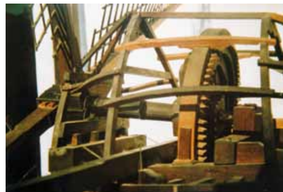
▲ De kap van het 'Bollee-model'. De penstoel heeft veel weg van die van de 6 e molen van de Hooge Boezem achter Haastrecht in zijn oorspronkelijke uitvoering (zie Molenwereld 2011-5-194). Een dekstuk ontbreekt en de springbeugel 'staat er alleen voor'. (foto ing. J. den Besten).
