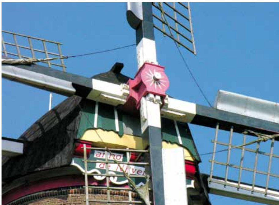
▲De as van de molen van Ravenstein is een oude Enthoven-as, gegoten in 1847 voor de Zuidplaspolder, zoals blijkt uit het opschrift: W: IJzerman Dijkgraaf. Hoezeer de zuinigheid de wijsheid bedroeg blijkt wel uit het feit dat er nu nog minimaal zes assen van de dertig voor 1880 gesloopte Zuidplasmolens bestaan. Ze zijn inmiddels alle meer dan 130 jaar oud. Ze doen dienst door het gehele land; tot in Vlaanderen toe (Rumbeke). De 24 andere zullen wel niet versleten zijn geweest (foto Donald Vandenbulcke, 6 september 2006).
