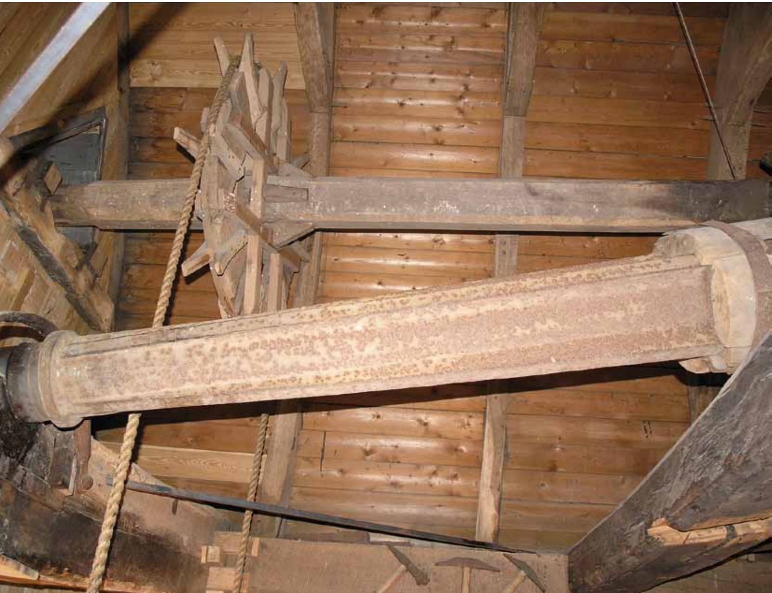
▲ De standerdmolen van Sprang-Capelle heeft een bijzonder lange NSBM-as (foto Willem Jans, 28 januari 2006).
