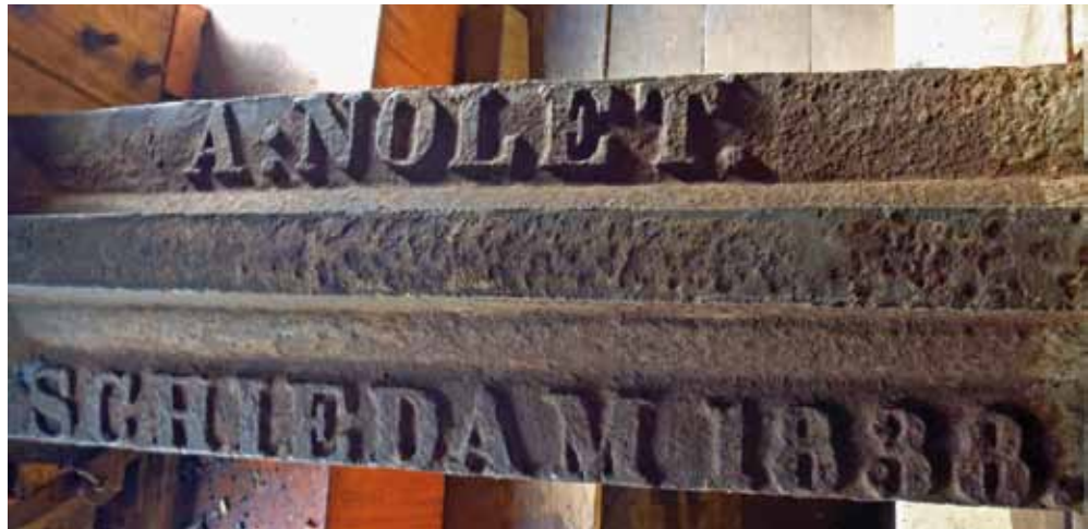
▲De as van De Vrijheid in Schiedam mag van buitenaf zijn herkomst niet verraden. De binnenkant sluit iedere twijfel uit. Zowel het fabrikaat als het gietjaar 1838 zijn pontificaal meegegoten. Het is zo de oudste gedateerde as van Nederland (foto Garrit Hendriks, 20 oktober 2011).
