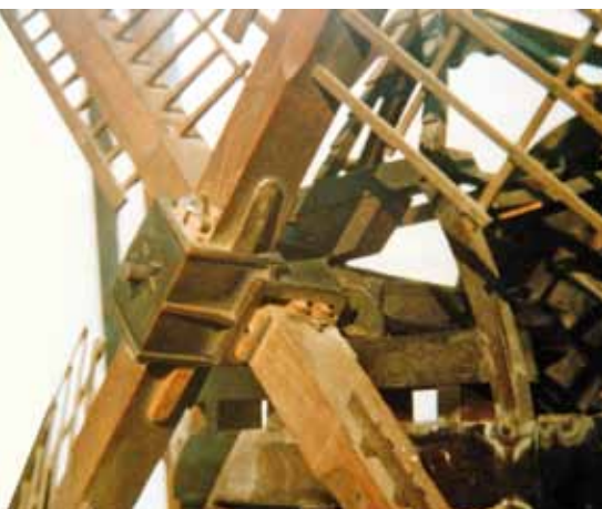
▲De askop van het Bolleemodel komt nog het meest overeen met het model van de as van Nederwaardmolen 2. De verstevigingen tussen de beide ashuizen zijn duidelijk aanwezig, terwijl die - merkwaardig genoeg - op de as van de molen van Wouwse Plantage ontbreken (foto ing. J. den Besten).
