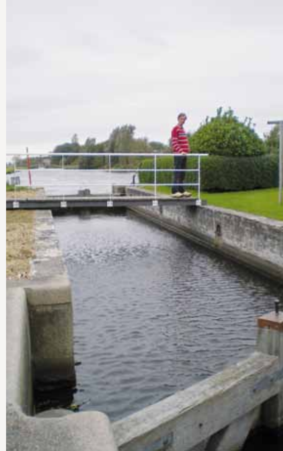
▲ Naast de molen is een schutsluis, waardoor schuiten vanuit de Kerkvaart in de polder gescht kunnen worden. De smalle kade links scheidt de Kerkvaart van de Oostvaart van de Hazerswoudse droogmakerij met weer een ander waterpeil. Deze vaart voerde het water van de ondermolens van deze polder naar de twee bovenmolens aan het einde van de Kerkvaart (foto Andries Veloo, 11 oktober 2011).
