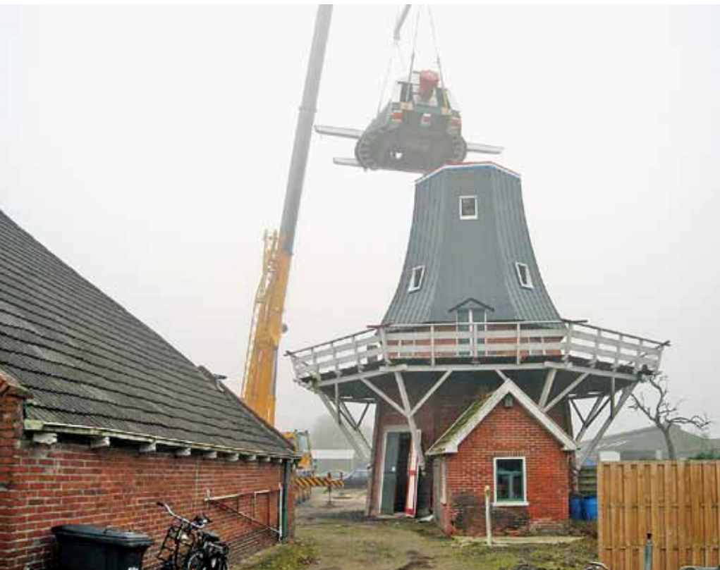
▲Het plaatsen van de kap op molen Windlust te Overschild (foto: L. Groenewold, 9 november 2011).
