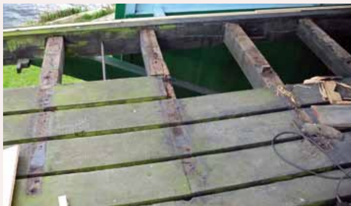
▲ Het vernieuwen van de zaagvloer van paltrok houtzaagmolen De Gekroonde Poelenburg: de opgebroken oude vloer (foto, 20 september 2011).
