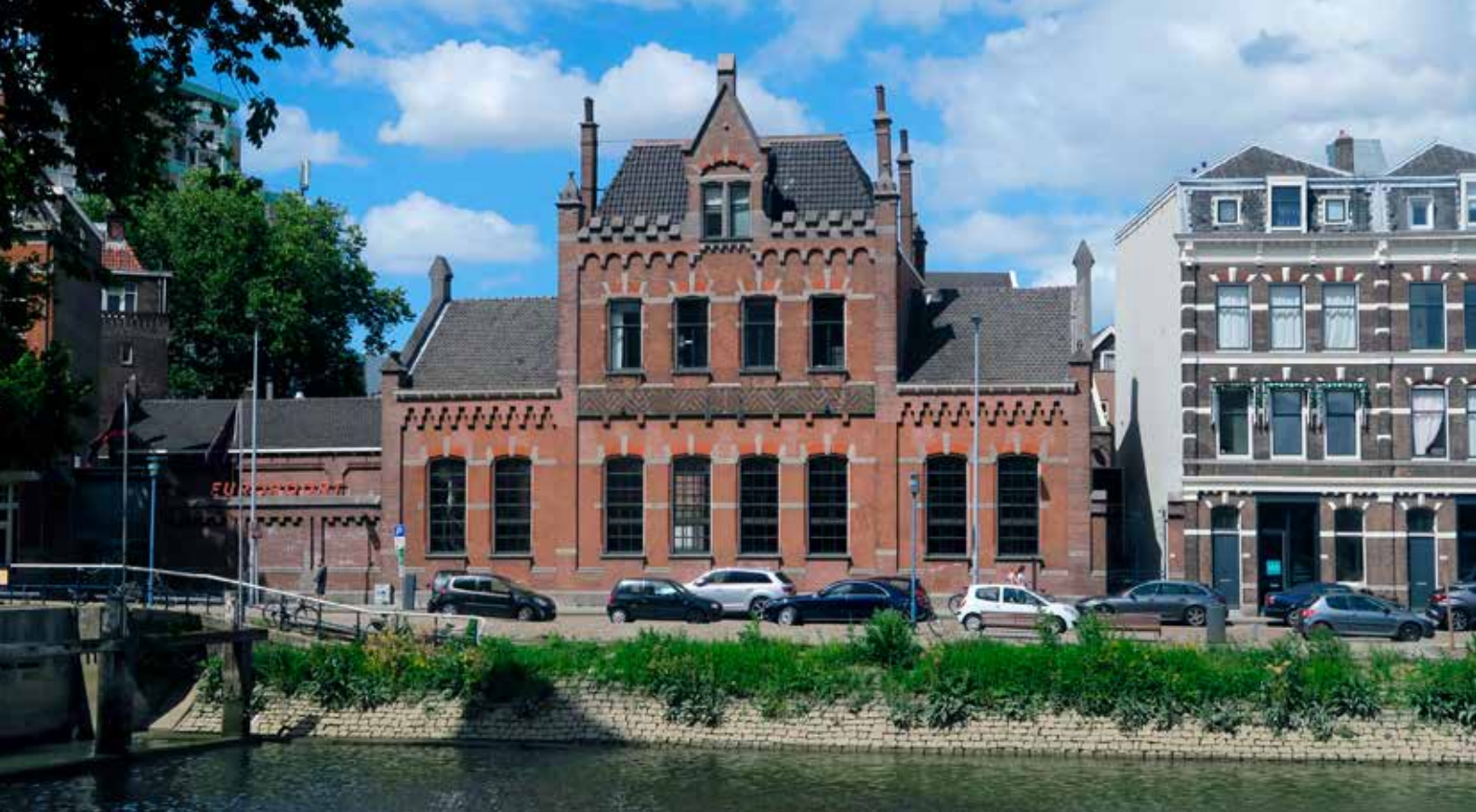
Aan de Admiraliteitskade in Rotterdam staat nog steeds het voormalige stoomgemaal, dat in 1899 de taak overnam van de boezemmolens en het oude stoomgemaal bij de Oostpoort. In 1977 werd zijn taak overgenomen door het nabijgelegen nieuwe gemaal Mr. U.G. Schilthuis (foto Erwin Esselink, 28 juni 2020).
