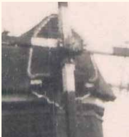
Uiteindelijk bleven er twee boezemmolens over als kandidaat voor de naar Apeldoorn verplaatste molen: no. 2 en no. 4. Vergelijking van de baarden gaf de doorslag. Links de molen van Vorderman, rechtsboven molen no. 2 en rechtsonder molen no. 4. De baard van molen no. 2 is duidelijk anders, die van molen no. 4 komt overeen met de Apeldoornse baard.
