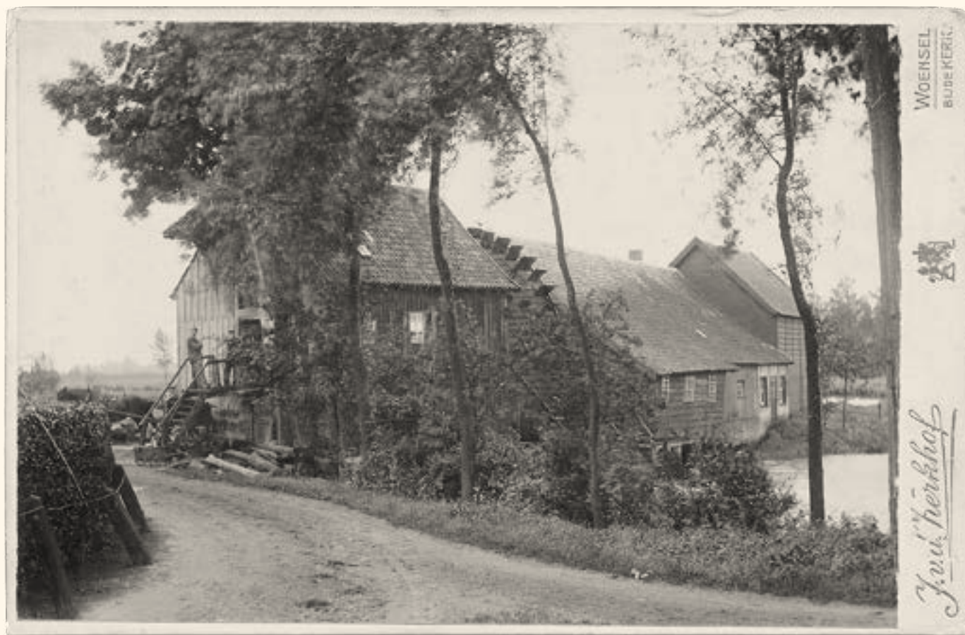
In 2005 was er een impasse over een bij de molen te bouwen restaurant. Toen kwam deze foto uit circa 1910 boven water met daarop afgebeeld een achter de molen gebouwde droogschuur van de leerlooierij van molenaarsoon E. van Hoorn. De schuur was inmiddels afgebroken, maar iedereen kon leven met de toverformule dat er sprake was van 'herbouw' in plaats van 'nieuwbouw' van een gebouw, dat vervolgens de functie van restaurant kreeg (collectie Piet-Hein van Halder).
