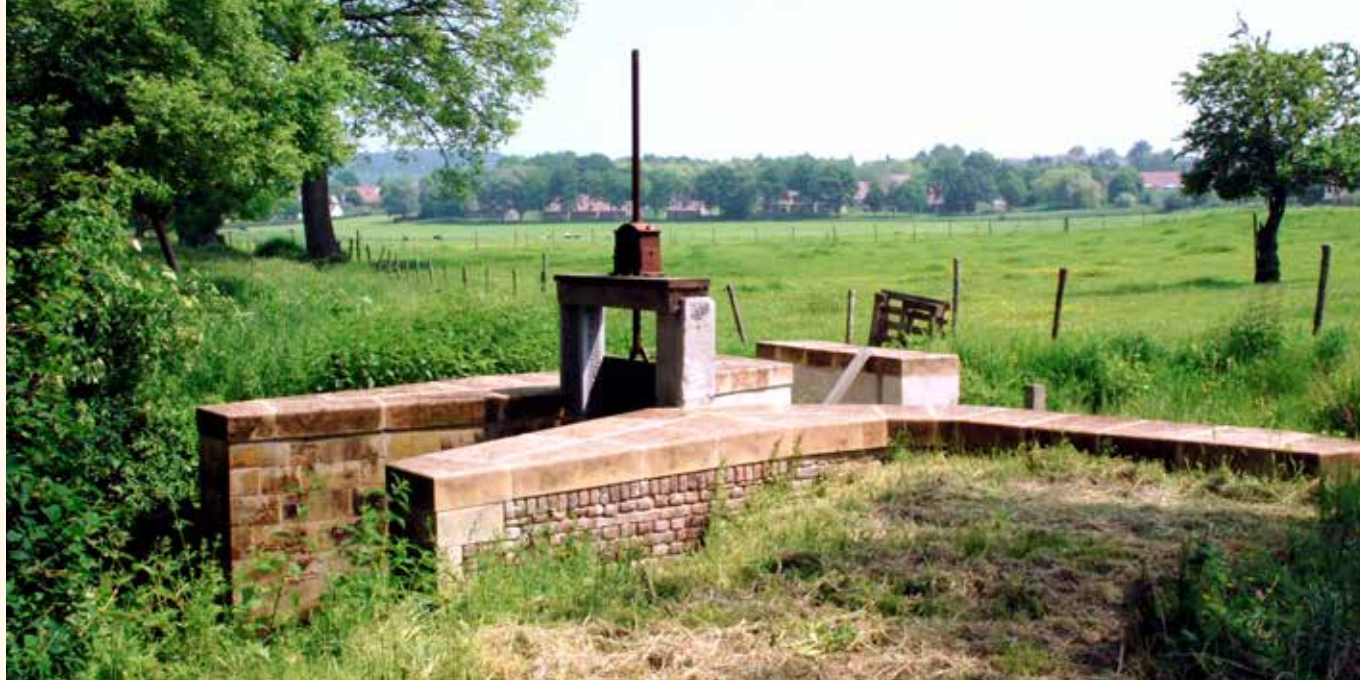
De stuw die het water verdeelt tussen de beek en de molentak. Bij het herstel zijn op grond van de oude situatie opnieuw mergelblokken aangebracht, een kostbare zaak (foto Dick Kenbeek, 24 mei 2012).
