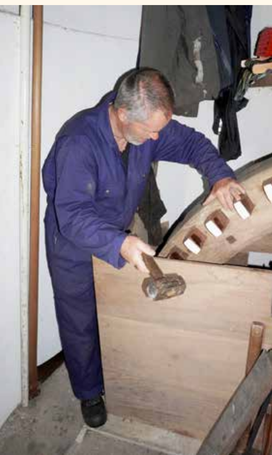
Vrijwillig molenaar Teun Waltman bezig met het vastzetten van kammen in het onderwiel van de Knipmolen, een poldermolen te Voorschoten (Zuid-Holland). Sinds 1977 is hij hier molenaar, maar hij verricht er ook het meeste onderhoudswerk. Teun is dan ook bijna 40 jaar werkzaam geweest als molenaar (foto Peter van der Drift, 28 april 2022).
