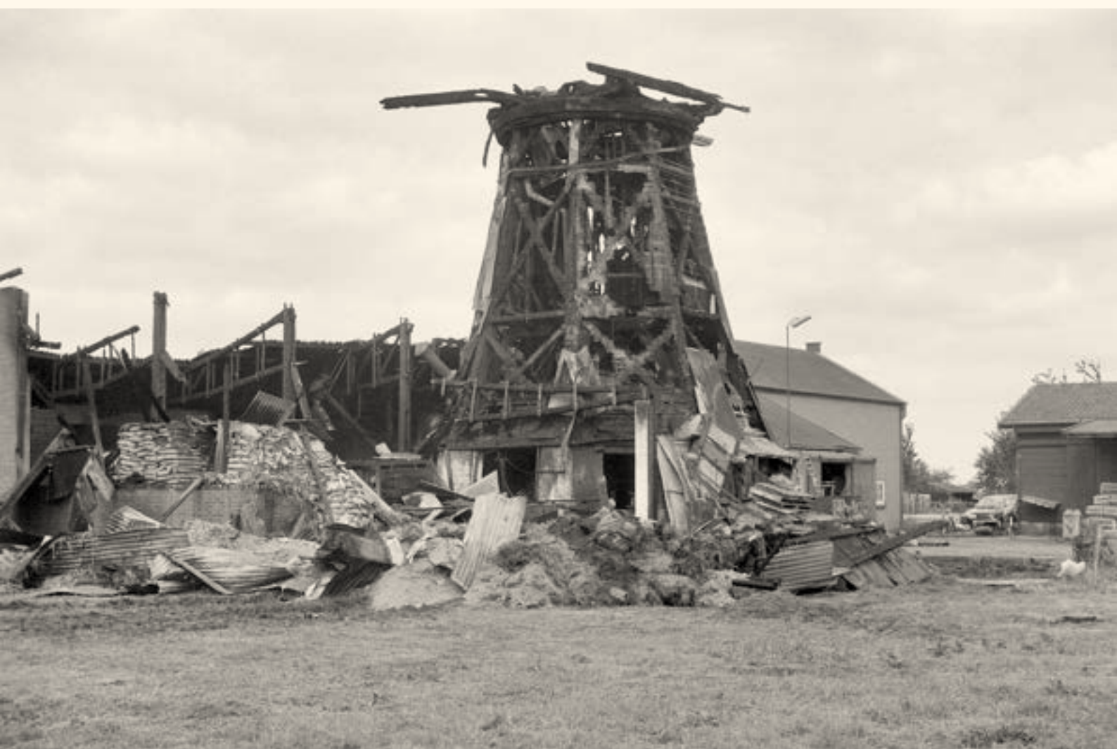
Na de brand bleef het zwaar beschadigde achtkant overeind staan, maar het zou in 1976 alsnog gesloopt worden (foto J.A. Heijdra, september 1972; fotoarchief Rijksdienst voor het Cultureel Erfgoed, documentnummer 148.105).
