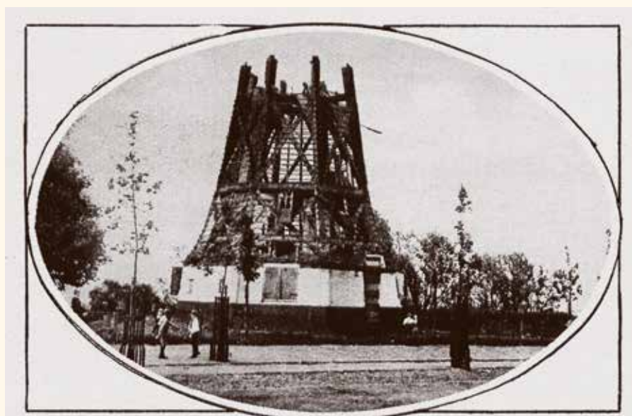
De vorige week is men begonnen, den molen aan de Boezemlaan tegenover de Wandeloordstraat, eertijds gebruikt voor de droogmaling van den achter den Noord Boezem, gelegen polder, te sloopen. Wat er nog van over is.
