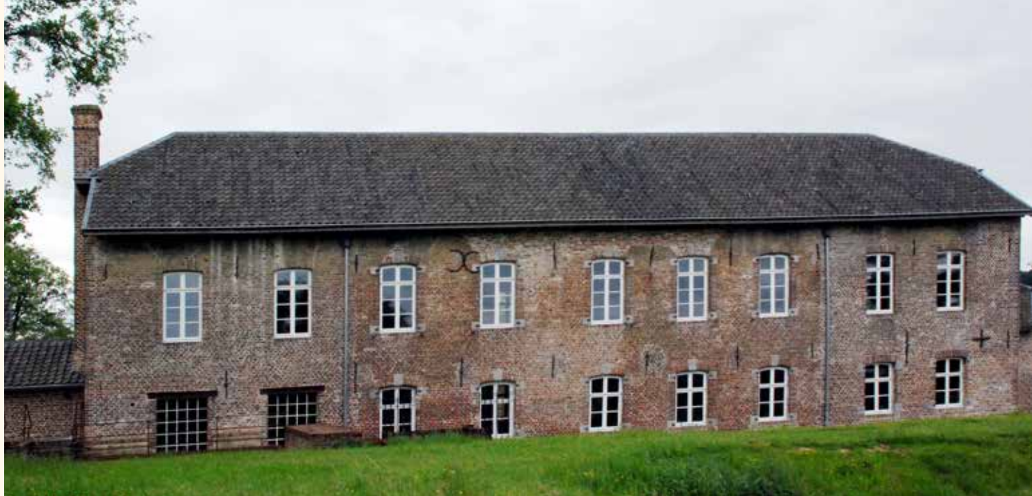
De achterkant van het herstelde hoofdgebouw. Ook hier is het verschil met de uitgangssituatie groot (foto Dick Kenbeek, 28 mei 2015).
