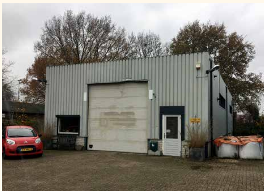
Het bedrijfsgebouw aan de Eendenpoelseweg in Malden. Aan de buitenkant is niet te zien dat hier de laatste Europese molensteenmakerij met dagelijkse productie is gevestigd.
