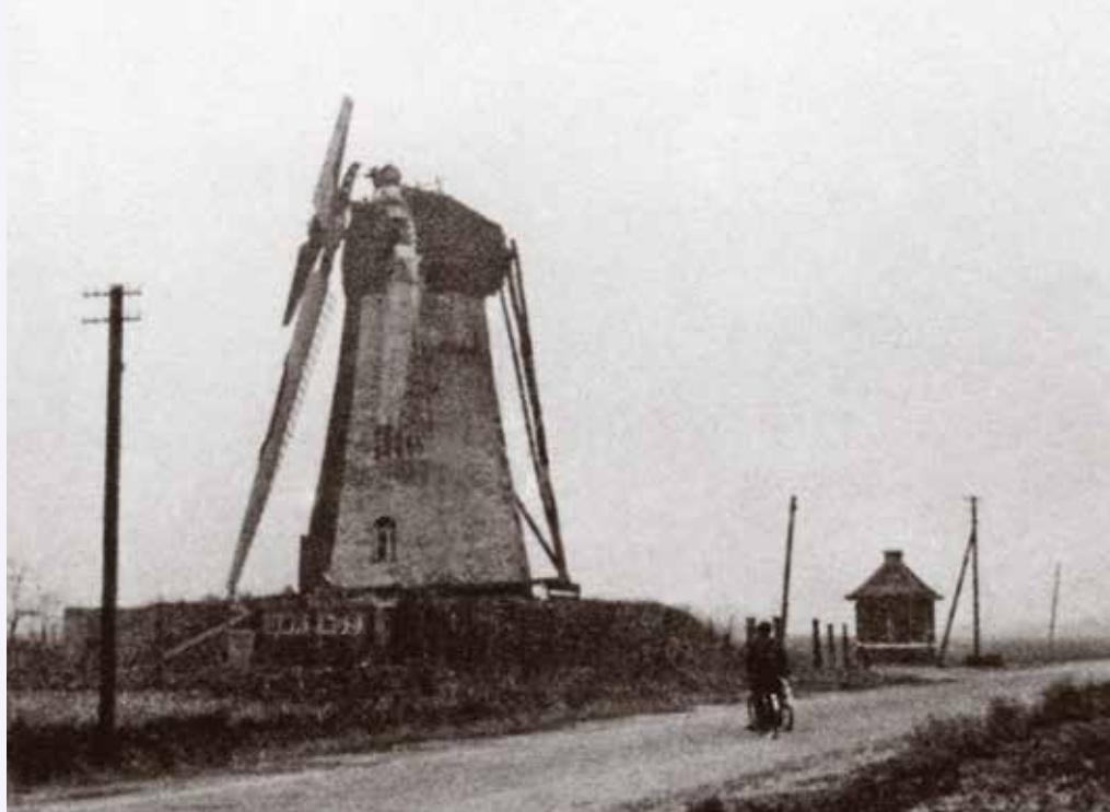
Eind 1943 brak de binnenroe van de Sint Anna. Bij het herstel werd het Dekkersysteem vervangen door Van Busselstroomlijnneuzen (collectie Erwin Esselink).
