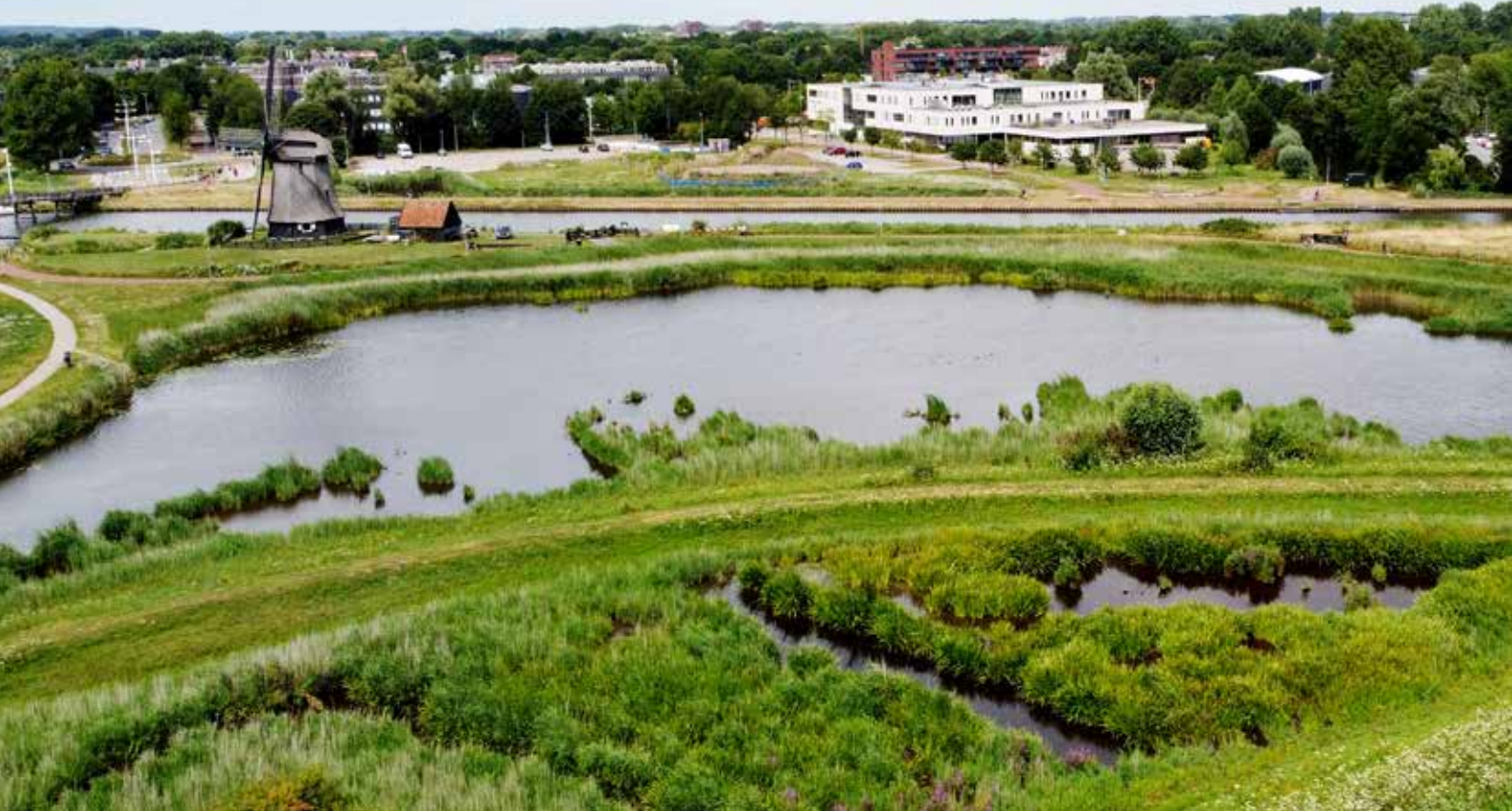
Het gebouw Van der Meij College in Alkmaar heeft een aflopende opbouw die rekening houdt met de biotoop van de tegenoverliggende strijkmolens. Het Programma van Eisen van de nieuw te bouwen Europese school sluit hierbij aan (foto Tom Kreuning).
