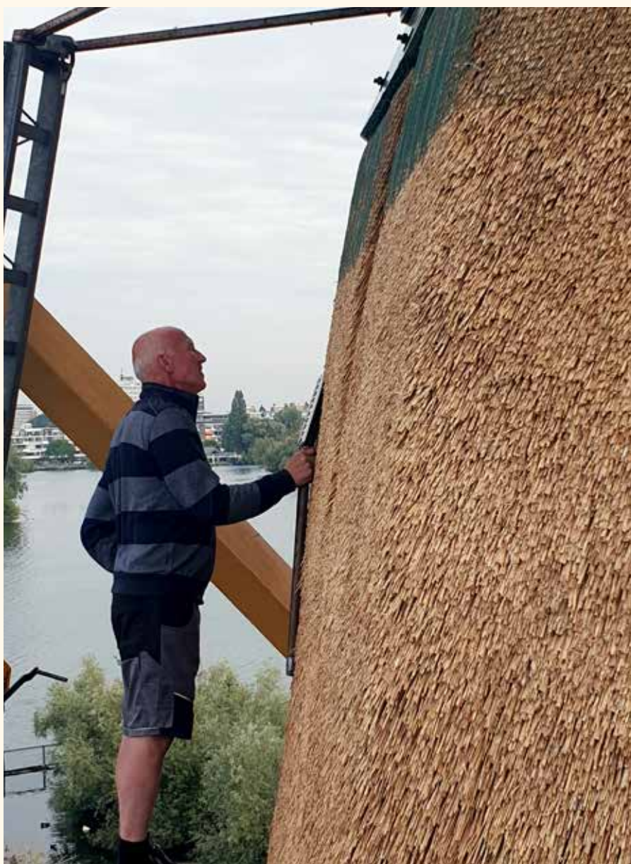
De steiger zakt. Henrie klopt de laatste rietstengels in perfectie op de Prinsenmolen in Rotterdam (foto Molenmakerij Grinwis, Michel Dellebeke, 2021).
