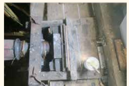
In de kap zijn nog Zaanse kenmerken terug te vinden: links de vangbalk met beugel en duim, rechtsboven de stutvang en rechtsonder de broek (foto's Erwin Esselink, 9 oktober 2021).
