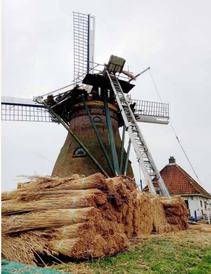
Vervangen van de kapbedekking bij de Stadsmolen in Leiden in december 2019 (foto Philip Pijnaken).
