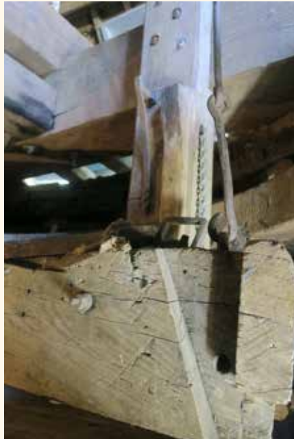
In de kap zijn nog Zaanse kenmerken terug te vinden: links de vangbalk met beugel en duim, rechtsboven de stutvang en rechtsonder de broek (foto's Erwin Esselink, 9 oktober 2021).
