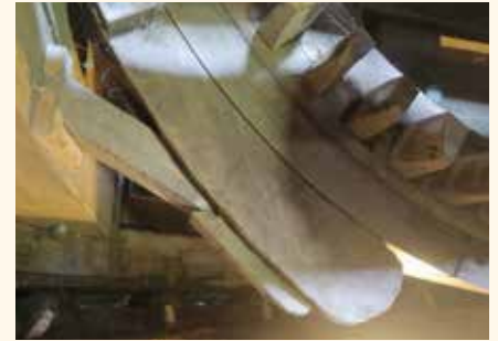
Het achterkeuvelens van de molen van Aalden naast dat van De Veering. Er zitten tientallen jaren tussen beide opnames, maar de vorm is identiek gebleven.
