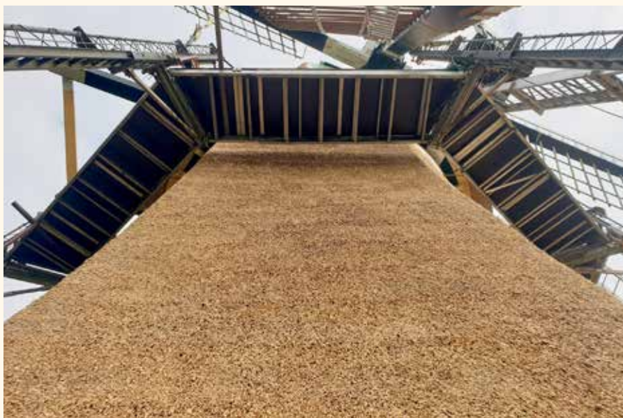
De steiger is bovenaan bij de Prinsenmolen in Rotterdam. Het rietdek is weer strak. Deze steiger is door Henrie zelf ontworpen en doet al vele jaren dienst (foto Molenmakerij Grinwis, Michel Dellebeke, 2021).
