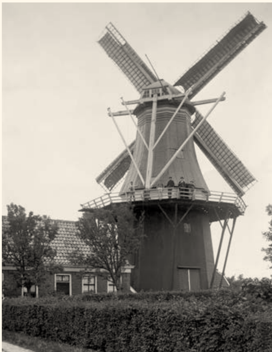
De molen die in Bierum stond van 1853 tot de sloop in 1928 was een van de eerste molens waar Hendrik Pot werkte. Deze koren- en pelmolen was met asfaltpapier gedekt, zoals vele van zijn soortgenoten in Groningen. De meeste poldermolens hadden daarentegen een bedekking met riet. Aan de bovenzijde van het achtkant waren de molens die geen rietdek hadden nogal eens afgewerkt met een rood-wit-blauwe sierlijst. De molen van Bierum had onder de sierlijst dan ook nog een bedekking met gepotdekselde delen (foto collectie Vereniging De Hollandsche Molen).
