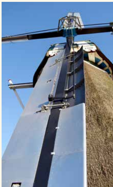
Sinds begin dit jaar heeft de molen in Kropswolde een uniek en geheel nieuw wieksysteem, dat een ontwerp is van de molenaar en de molenmaker samen (foto Harmannus Noot, maart 2022).
