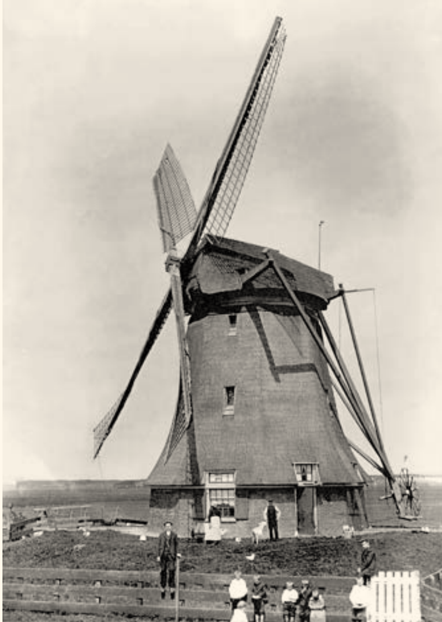
Bovenmolen nummer 6 rond 1900 vanaf de dijk langs de Kerkvaart. Te zien is dat de molen is vervijzeld omdat de oorspronkelijke ingangseur is dichtgemetseld, terwijl het bovenraam nog aanwezig is. Aan de afschuiningen van het ondertafelement voor het oude en nieuwe bovenraam kon Gerrit Keunen aannemelijk maken dat molen Windlust te Wolvega afkomstig is uit Mijdrecht (afbeelding fotokopie van ansichtkaart)
