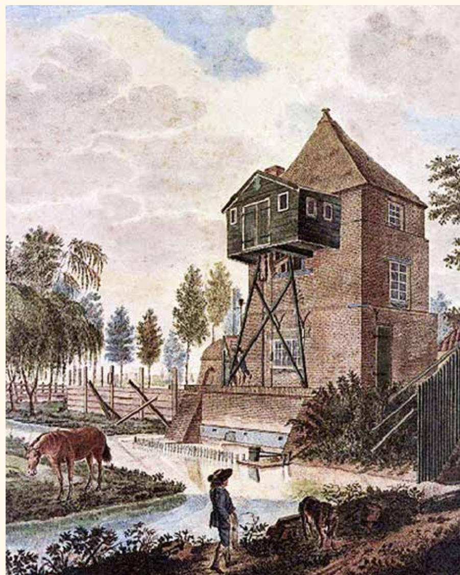
Het stoomgemaal van het Bataafs genootschap te Rotterdam in de polder Blijdorp. Herbouw te Nieuwkoop en later Mijdrecht ging uiteindelijk niet door (afbeelding uit Hoge dijken, diepe gronden).
