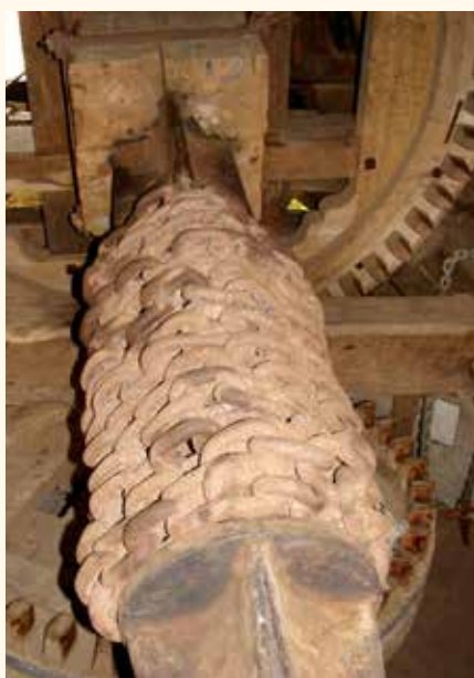
Het peneinde van de Boddaert-as in Biervliet is met een zware ketting omwikkeld tegen opwippen, maar meestal was een verzwaring niet nodig (foto Jan de Witte, 17 augustus 2013).
