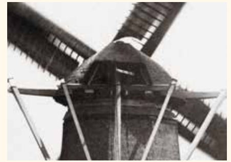
Het achterkeuvelens van de molen van Aalden naast dat van De Veering. Er zitten tientallen jaren tussen beide opnames, maar de vorm is identiek gebleven.
