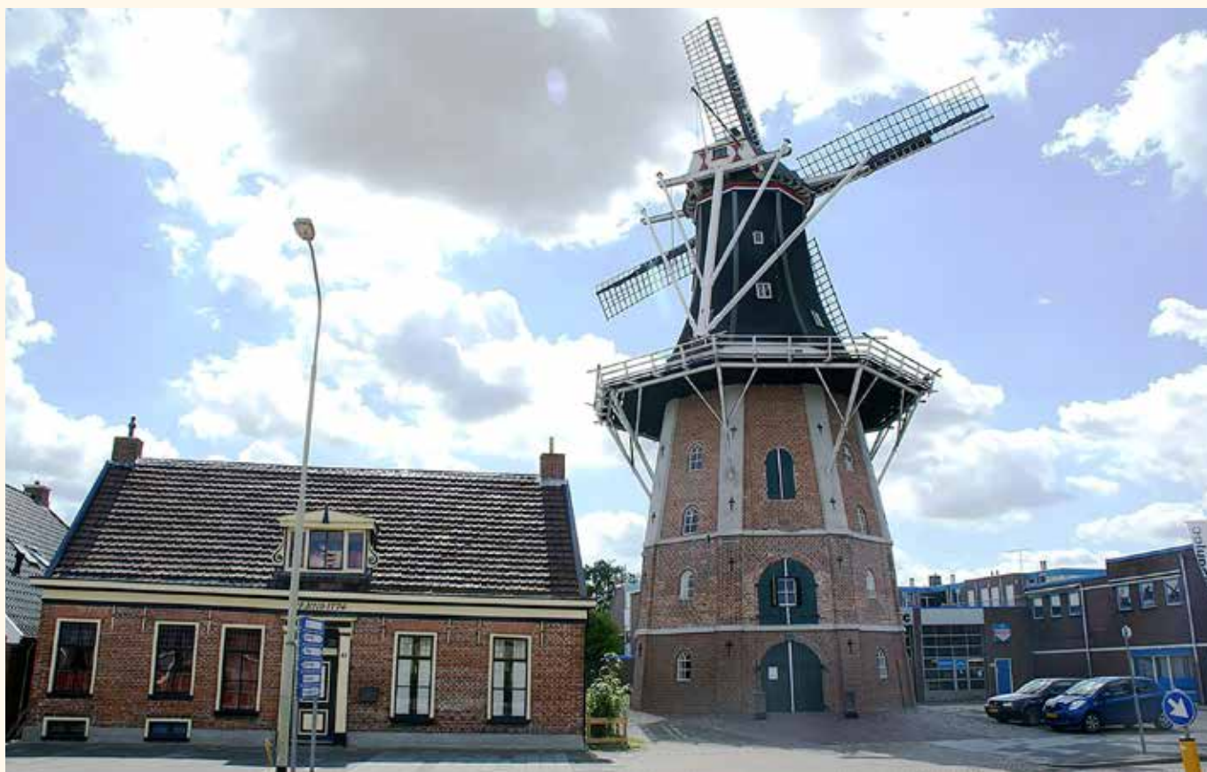
De stenen onderbouw van korenmolen Edens in Winschoten is al twee keer verhoogd (in 1870 en in 2006/2007) vanwege ontwikkelingen in de omgeving die de molenbiotoop aantastten (foto Michel Dellebeke).
