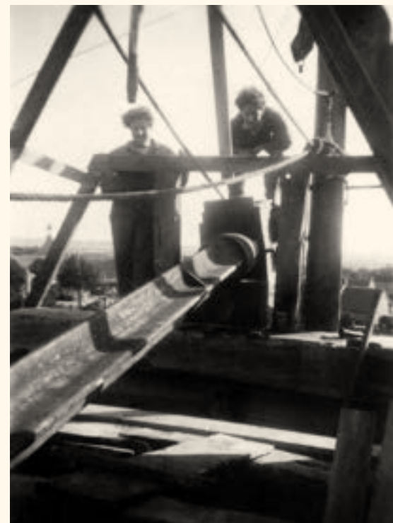
In 1948 herstelden de gebroeders Harrie (links) en Bèr Beijl uit Afferden de oorlogsschade aan de standerdmolen van Retranchement. Goed te zien is hoe iel een Boddaert-as is en dat de as maar één dwarsrib heeft (collectie Vereniging De Hollandsche Molen).
