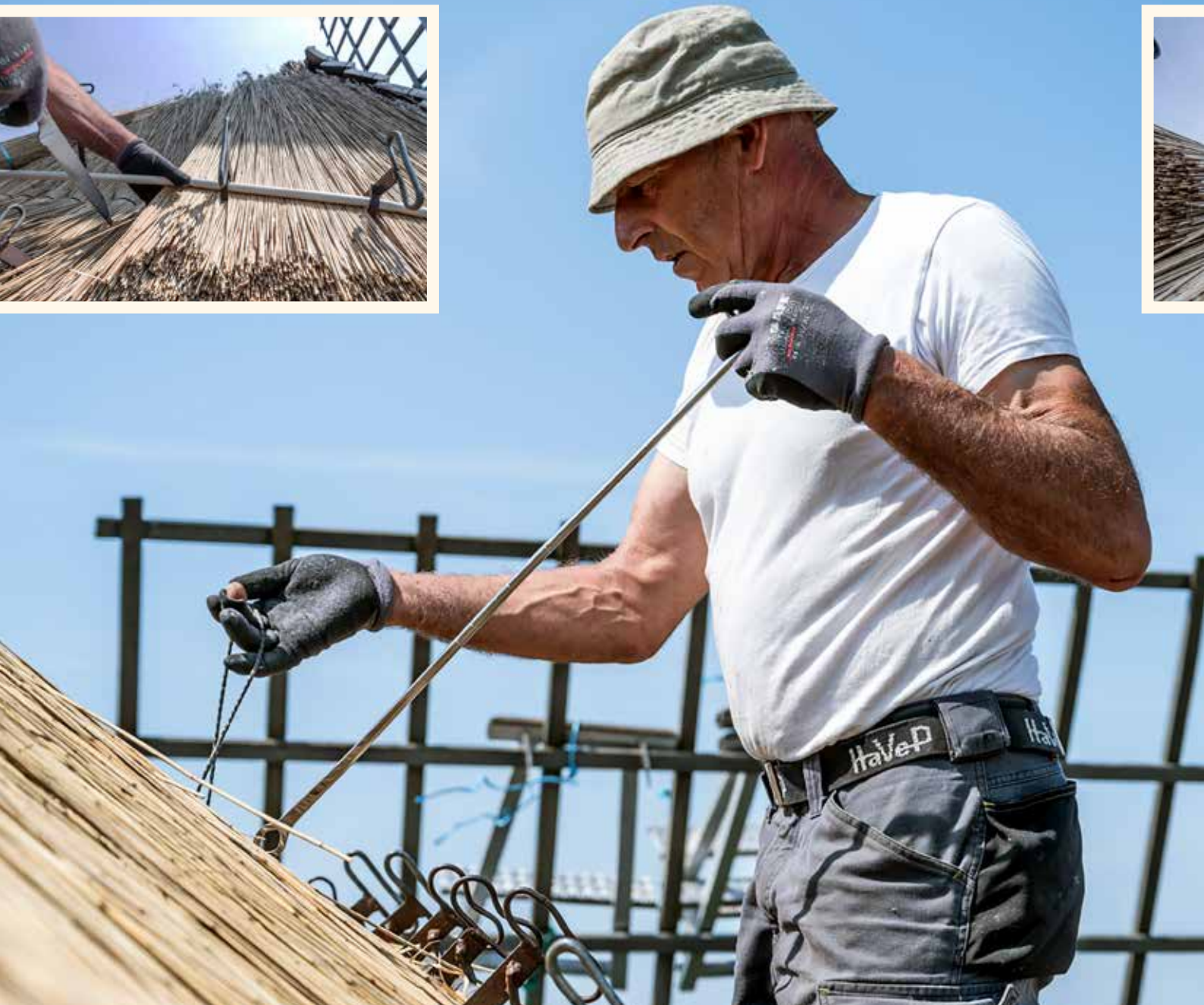
Het naaien van de kapbedekking door Arjan Visser op De Gooyer in Amsterdam (foto Jan Reinier van der Vliet, 2021). Inzet: Het vormen van de kapbedekking op De Gooyer. De bossen worden uitgespreid en met een buis op spanning gelegd voordat ze worden vastgebonden (foto Jan Reinier van der Vliet, 2021).
