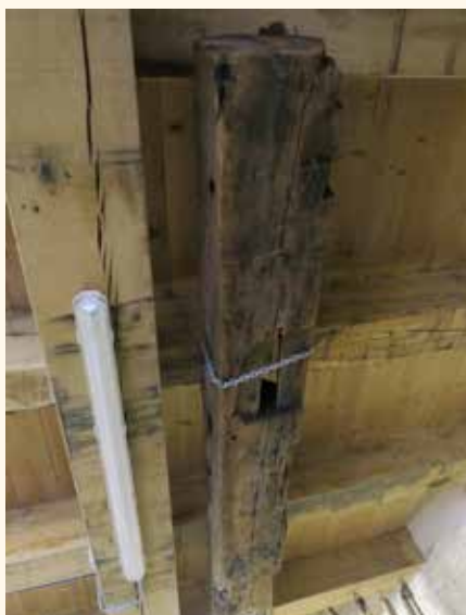
In 2010 werd de vloer van de maalzolder vernieuwd. Een oude balk bleef bewaard en werd opgehangen onder de nieuwe vloer. Zo te zien gaat het hier om een achtkantstijl (foto Erwin Esselink, 9 oktober 2021).
