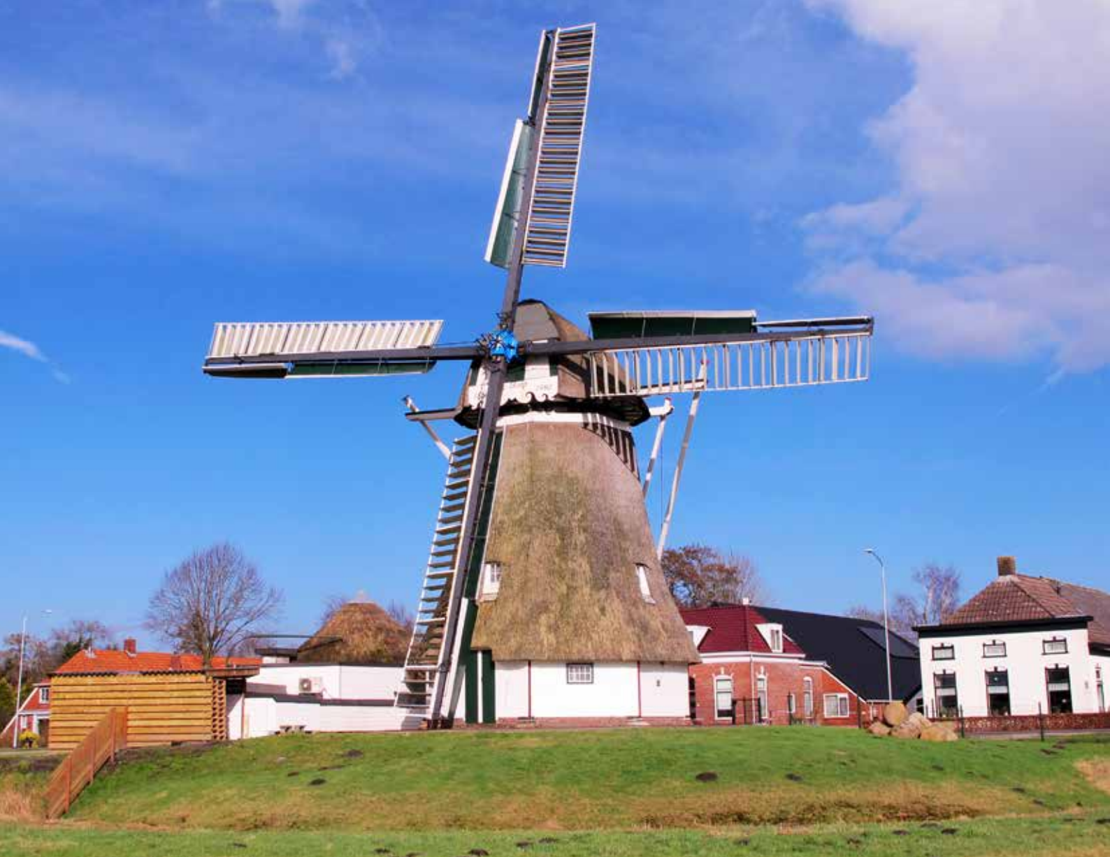
De Hoop in Kropswolde nog met zelfzwichting. Op het voorhek waren fokken aangebracht, die echter toelopend naar de as veel breder waren dan normaal (foto Erwin Esselink, 5 maart 2017).
