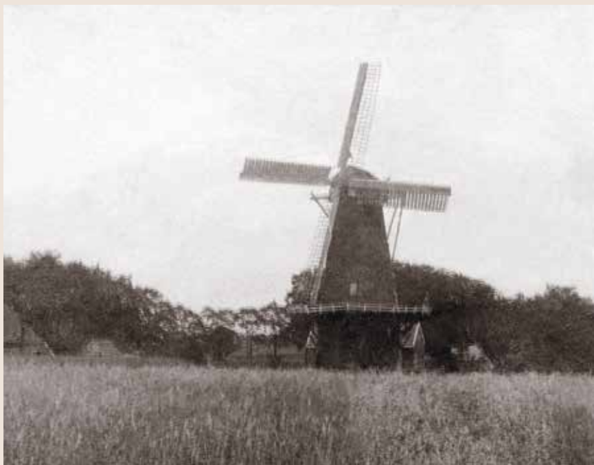
In 1896 bracht Jan Vliegghuis zelfzwichting aan op de binnenroede van de molen van Beins te Borger naar ontwerp van de molenmakers Wiertsema uit Sappemeer. Detail van een prentbriefkaart die amateurfotograaf Thöne uit Nieuw-Buinen in 1916 stuurde aan molenaar Snater, sinds 1907 eigenaar van deze molen. Overigens werd de zelfzwichting later weer vervangen door oud-Hollandse ophekking (collectie Vereniging De Hollandsche Molen).
