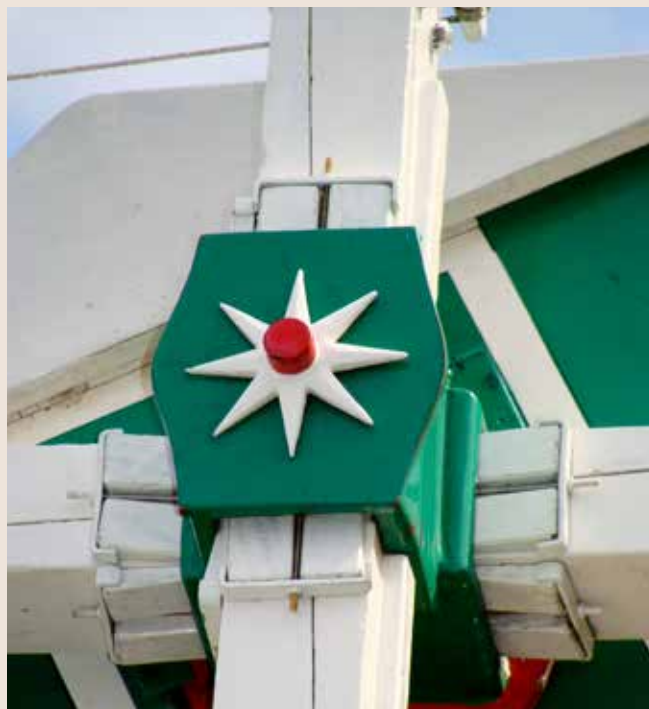
De as van molen Unicum is weliswaar gegoten bij Boddaert & Co. N.V., maar lijkt niet op de gangbare assen. Ster en walpen zijn pas later toegevoegd. (foto Jan de Witte, 21 februari 2015).
