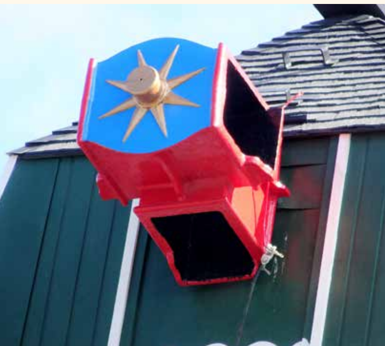
Askop van de molen van Nieuwvliet. Alle bekende Boddaert-assen hebben een overhoeks gegoten ster. Ook de vorm van de walpenplaat is overal gelijk (foto Jan de Witte, 6 maart 2021).
